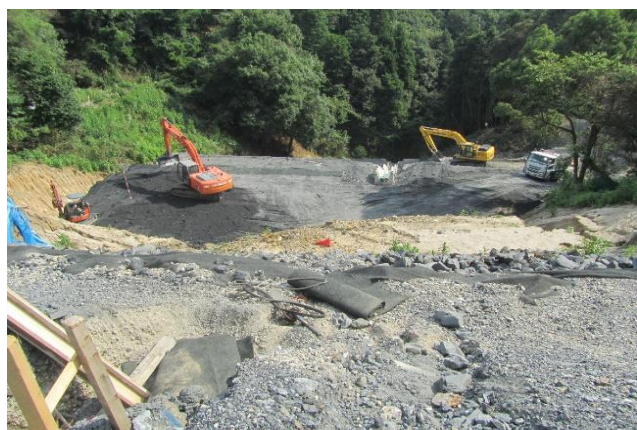
バス道路から工事現場を見る
