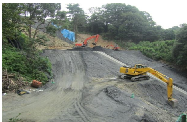
下から工事現場を見る
