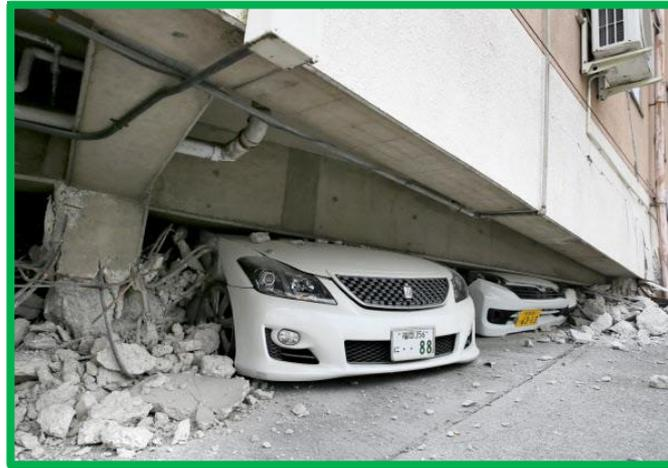
マンション1階の柱崩壊による
