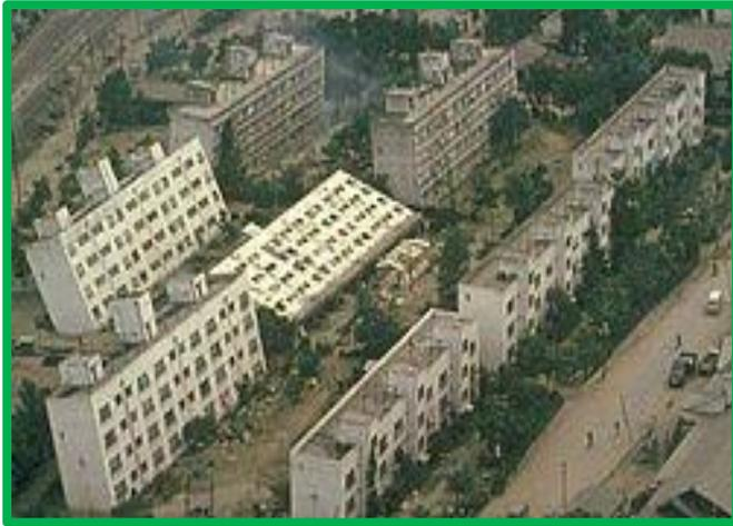
液状化による建物倒壊（新潟地震）
